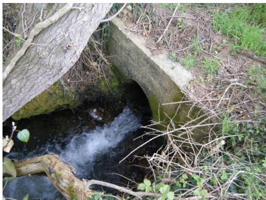
Vue de la buse avant travaux
