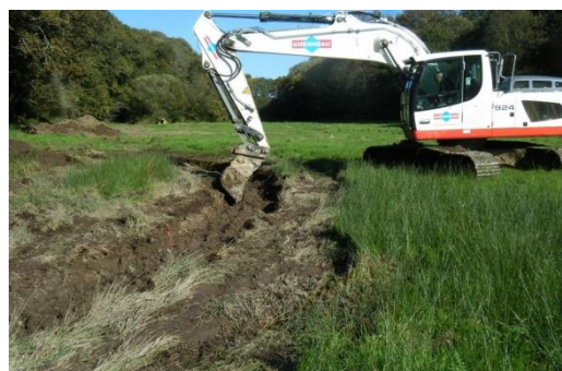
Terrassement du nouveau lit à méandres
