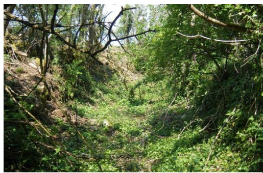
Zone d'écoulement avant travaux
