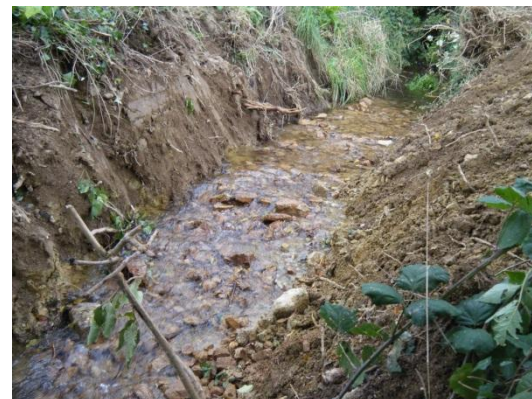
Vue du ruisseau après travaux
