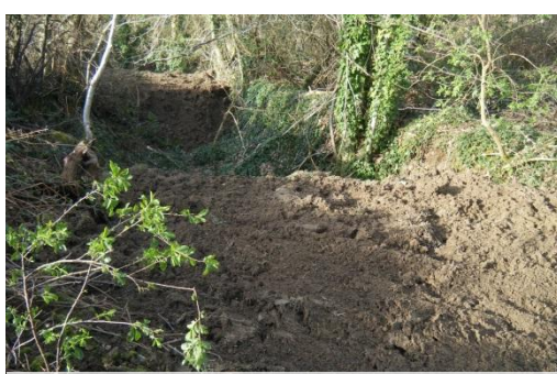
Terrassement des merlons de terre
